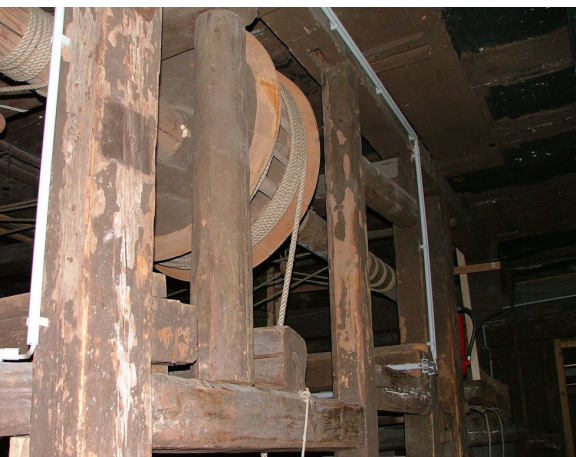
Welle zum Austausch der Soffitten (Foto: Dobritzsch)
