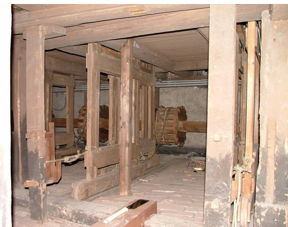
Blick in die Unterbühne mit Wellbaum zur Synchronisation des Kulissenzuges und Kulissenwagen (Foto: Dobritzsch)
